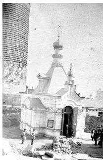
Часовня апостола Варфоломея в Баку на предполагаемом месте казни апостола. Разрушена в 1937 году
