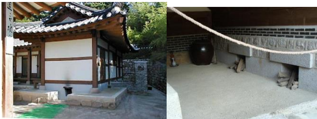
Şəkillər 30,31. Ondol sistemi ilə qızdırılan - Koreya ənənvi ev
