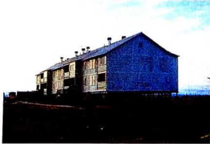
Daimi donuşluq sahələrində binaların dirəklər üstə tikilir.
