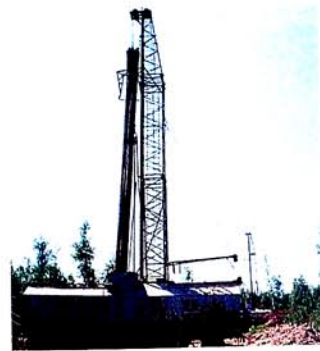
Dolmatovsk uran yatağındakı qazma diazğı.
