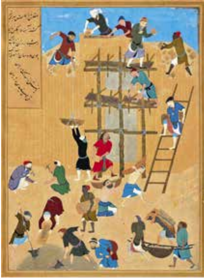
Строительство дворца Хаварнак
