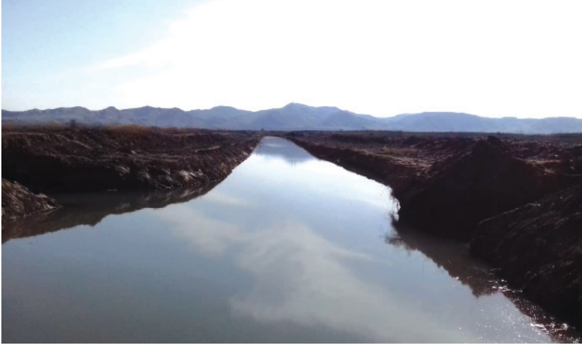
Şəkil 4.6. Suvarma kanalı (Cocuq Mərcanlı kəndi)
