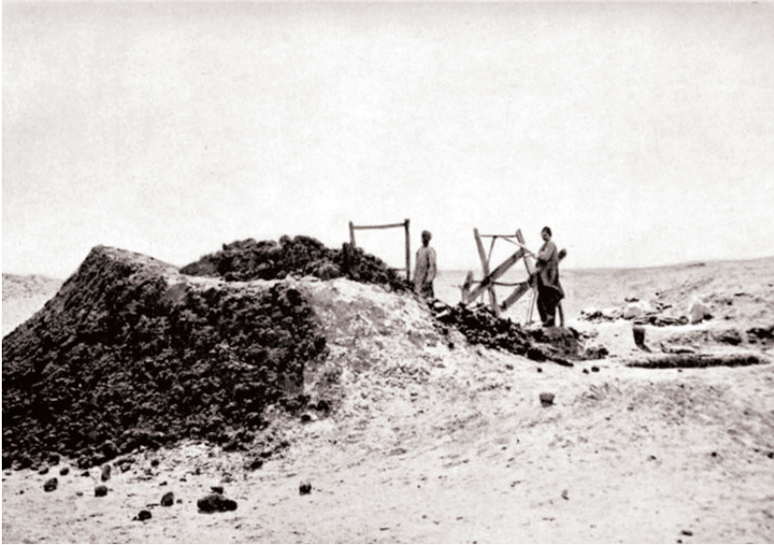
Şəkil 3.3. Kəhriz quyusunun qazılması
