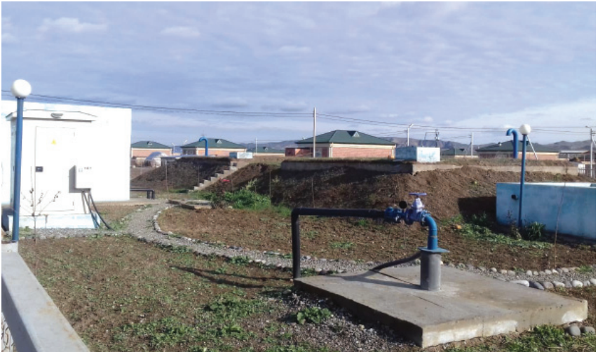
Şəkil 4.5. Subartezian quyusu (Cocuq Mərcanlı kəndi)
