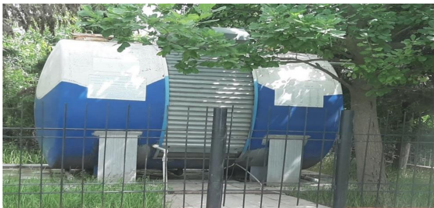
Şəkil 1.29. Modul tipli sutəmizləyici qurğu (Əlicançayın sol sahili, Salamabad kəndi)
