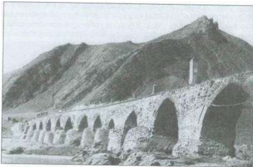
Худавердинский мост через Аракс. Современная фотография.
