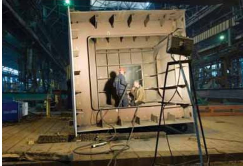
Qaynağın keyfiyyətinə ultrasəs üsulu ilə nəzarət edilməsi.
