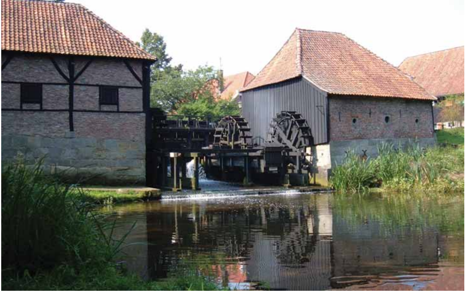
Axar suyun kinetik enerjisi ilə işləyən su dəyirmanı.
