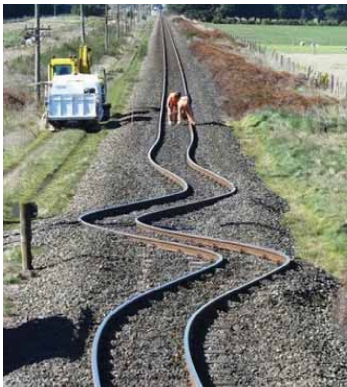
Zəlzələsindən sonra dəmir yolu xəttinin vəziyyəti. Yeni Zelandiya. 2010 -ci il.
