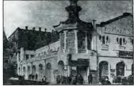
"Mikado" (indiki S. Fuzğun adına Dövlət Rus Dram Teatrı) teatrının binası
