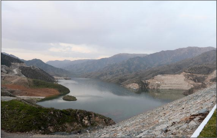
Şəkil 1. Şəmkirçay su anbarı.
