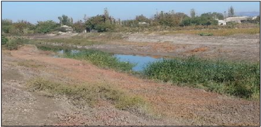
Şəkil 44. Baş Şirvan kollektorunun bir hissəsinin qeyri-qənaətbəxş vəziyyəti.
