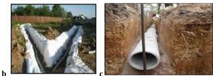
Şəkil 11. Horizontal drenaj (a,b,c).
