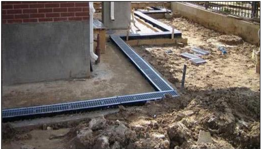
c - açıq tip dairəvi (və ya halqavari) drenaj.
