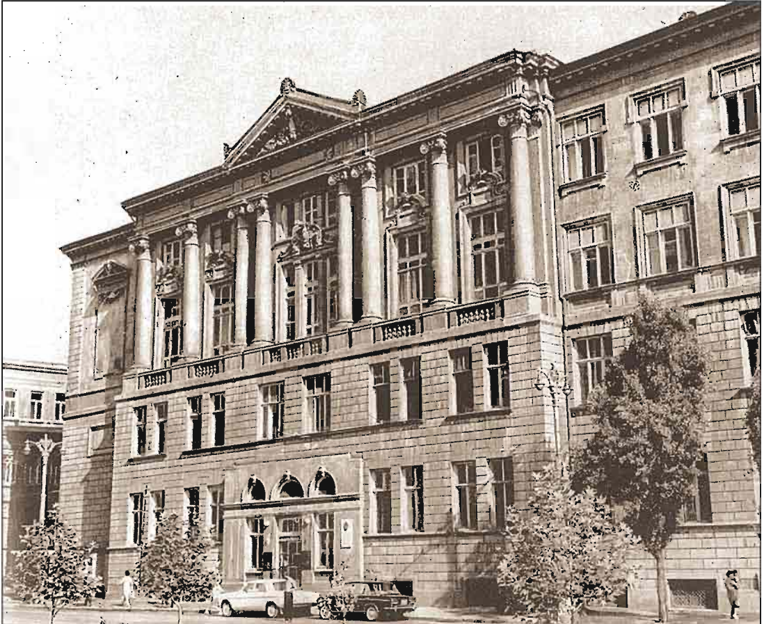
Balaxanskaya küçəsində kişi gimnaziyasının binası. Mülki mühəndis K.A. Borisoglebskiy. 1911-1913-cü illər. Здание мужской гимназии на Балаханской улице. Гражд. инж. К.А. Борисоглебский. 1911-1913 гг.
