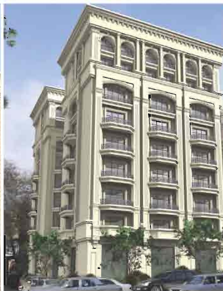
Bakı. Neftçilər prospekti, 89 ünvanında yerləşən bina yenidənqurmada sonra. Memar R.Babakişiyev
