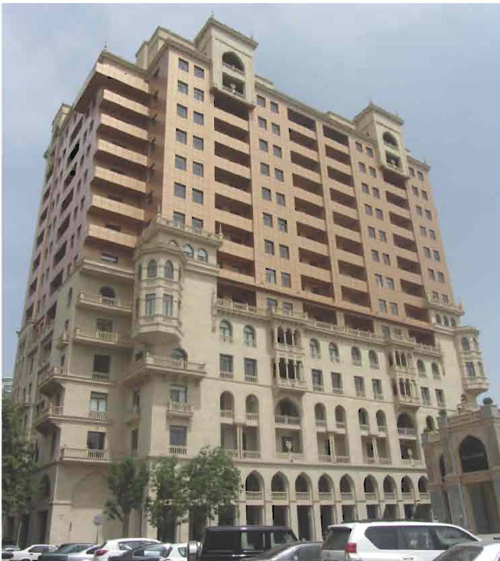
Bakı. Səməd Vurğun küçəsi ile Lev Tolstoy küçəsinin kəsişməsində yaşayış binası. Memar Ə.Əliyev
