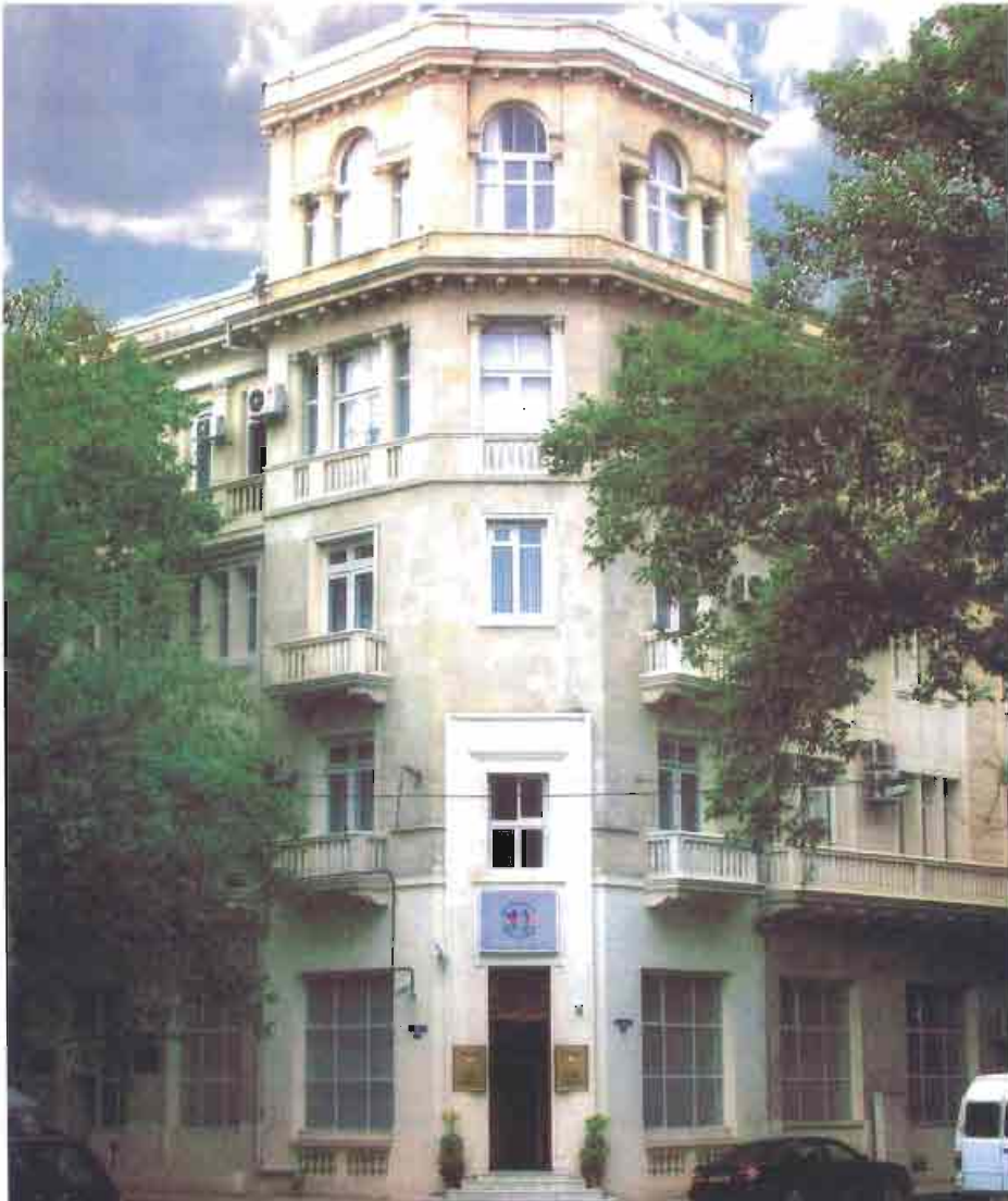
Bakı. Hidrometereoloji Proqnozlar Bürosunun inzibati binası. Memarlar S.Dadaşov, M.Hüseynov
