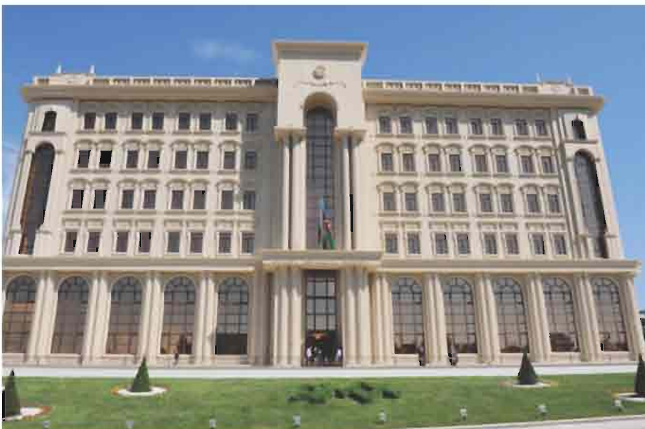
Bakı. Dövlət Miqrasiya Xidmətinin binası. Məmar İ.Orucov
