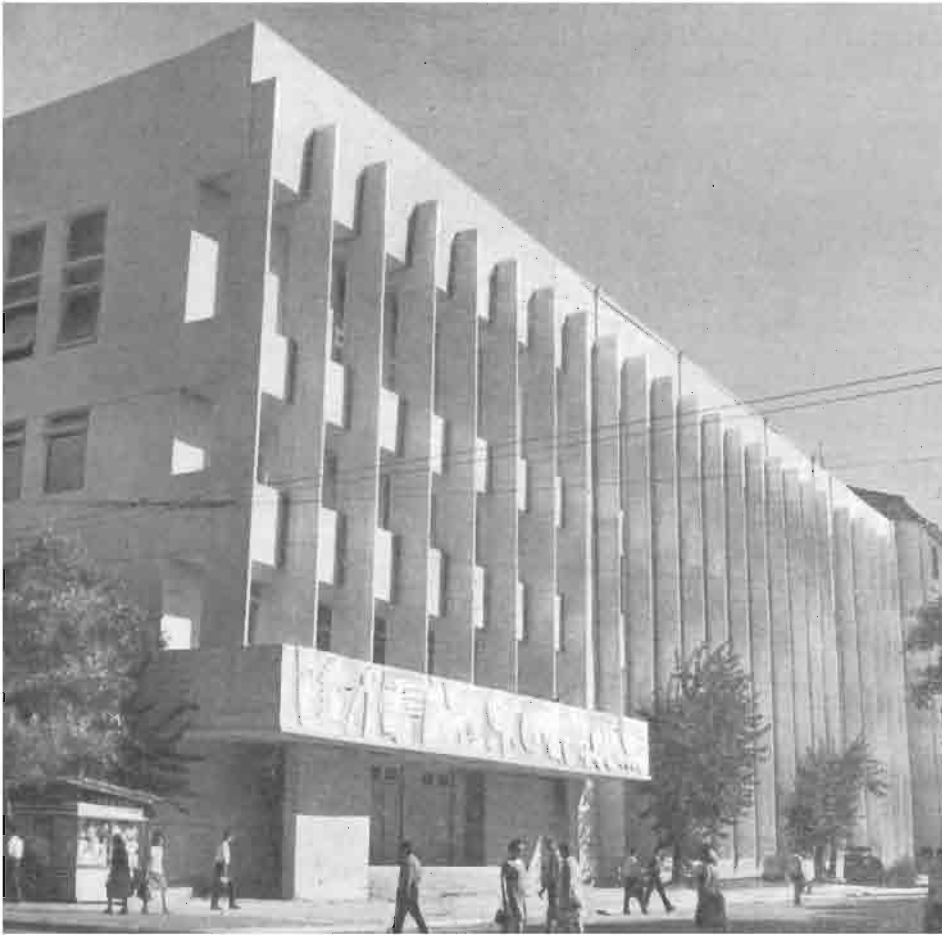
Bakı. Xaqani küçəsi ilə Bülbül prospektinin kəsişməsində inzibati bina (keçmiş Həmkarlar İttifaqı Konfederasiyasının İdman sarayı)
