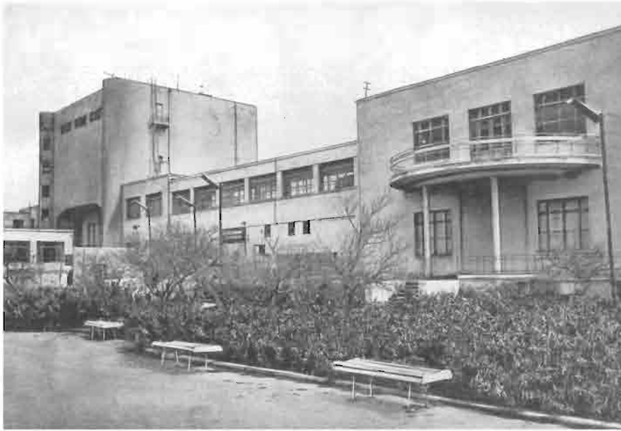
Bakı. Xocalı prospektində bank binası (keçmiş "Xətai" Mədəniyyət Sarayı)
