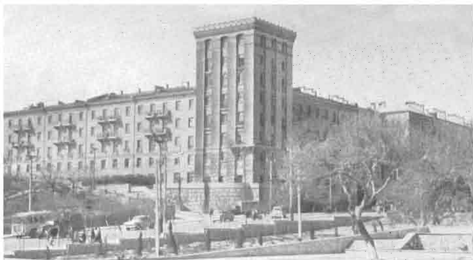
Bakı. Abbasqulu Ağa Bakıxanov prospekti ilə Murtuza Muxratov küçəsinin kəsişməsində yaşayış binası. Memarlar A.Borodatov, E.Kopeloviç
