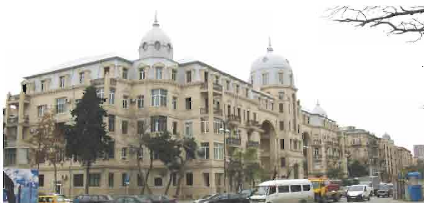
Bakı. Azadlıq prospektində yerləşən yaşayış binaları yenidənqurma işlərindən sonra.
