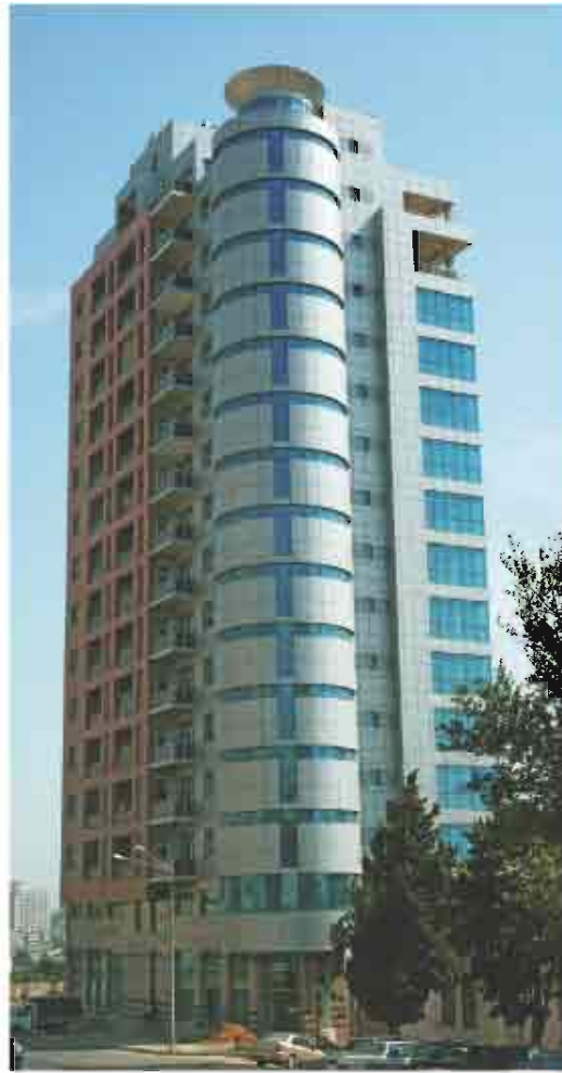
Bakı. Zərifə Əliyeva prospektində yaşayış binası. Memar F.Yüzbaşov
