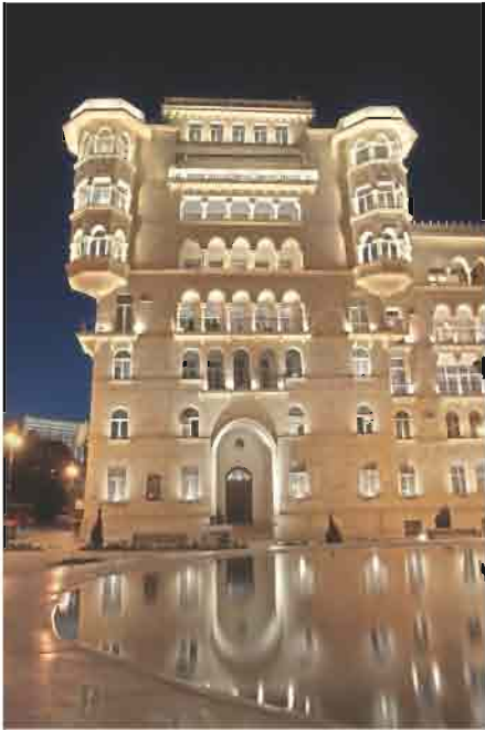
Bakı. Elm xadimlərinin yaşayış binası
