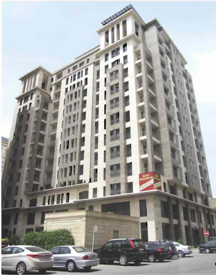
Bakı. Səməd Vurğun küçəsində yaşayış binası. Memar Durmuş Dilekçi
