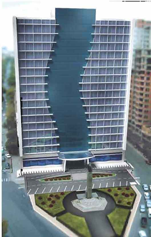
Bakı. "Respublika" mehmarxanasının binası yenidənqurmadan sonra
