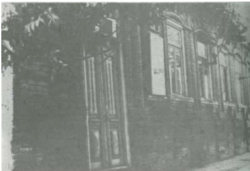
Hacı İbad Hacı Ələkbərovun evi. 1910-cu ildə tikilib.
