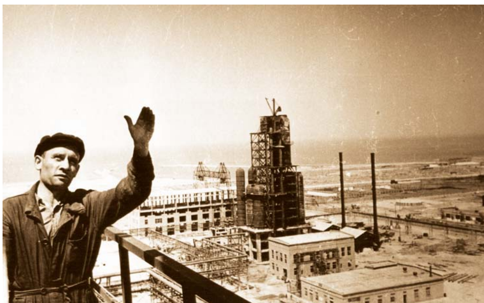
Kimya kompleksinin inşası. (1956)
