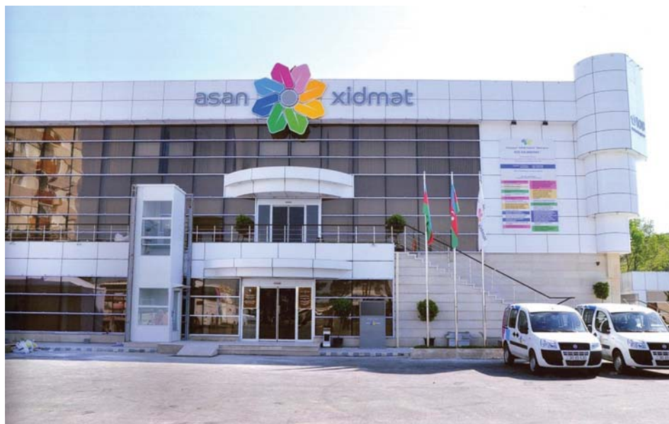
«Asan xidmət»in inzibati binası
