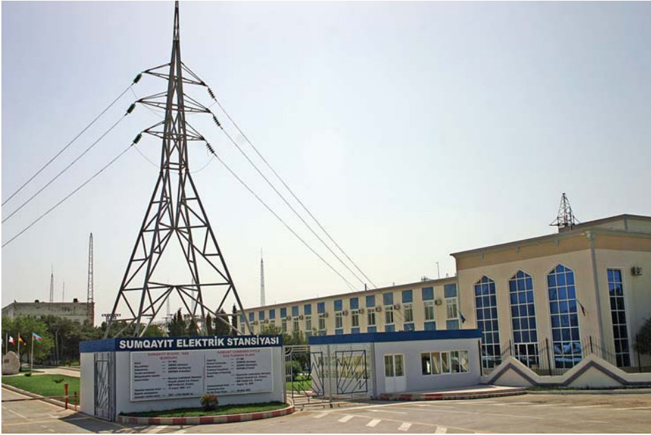
Yeni istilik elektrik stansiyası.
