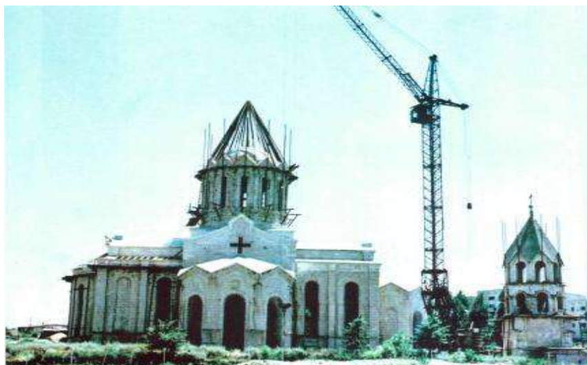
Alban kilsəsi bərpa zamanı. Şuşa şəhəri. 1984-cü il. Reconstruction of the Albanian Church. Shusha city. 1984. Реставрация албанской церкви. Город Шуша. 1984 год.
