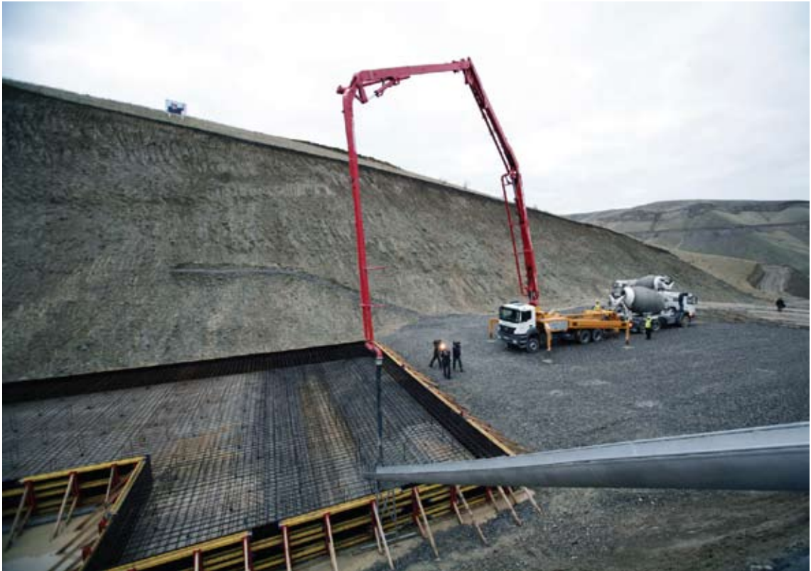
SES-in binasının özülühə beton verilir.
