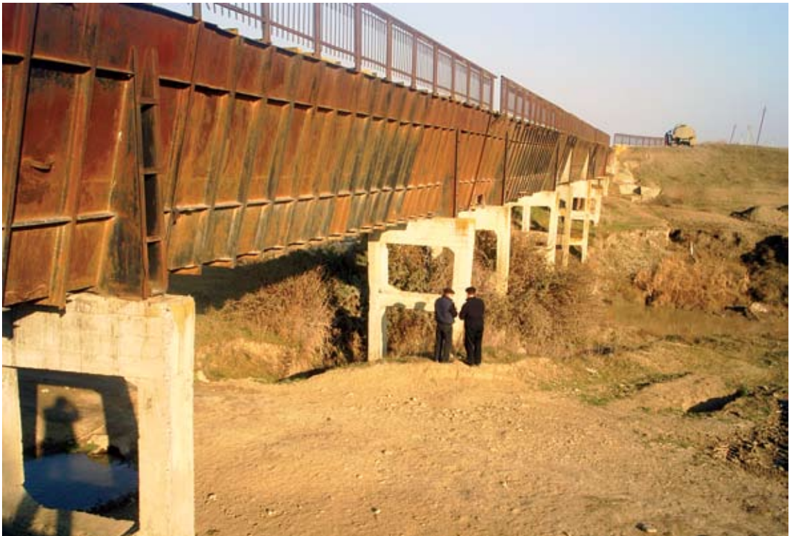
Yuxarı Şirvan kanalında akveduk
