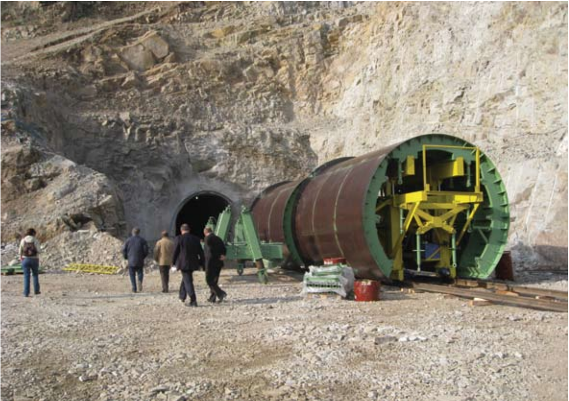
Şamkirçay su anbarında tunel tikilir
