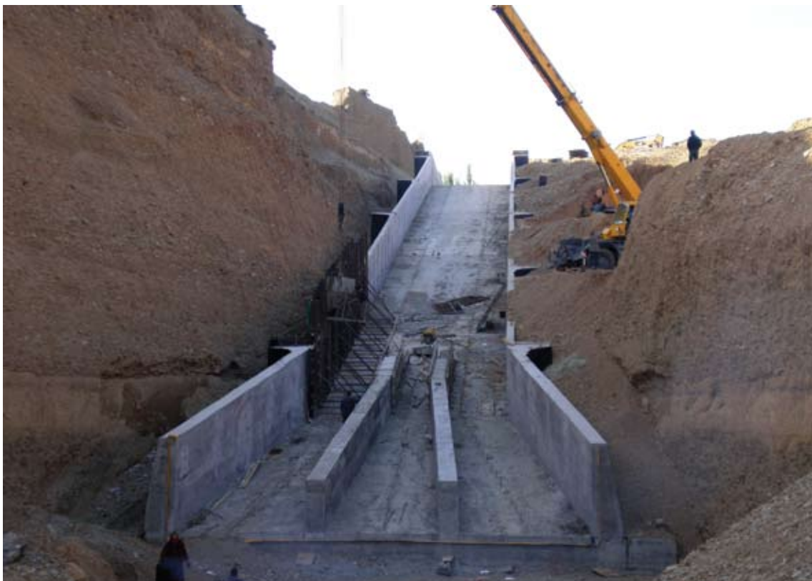
Tovuzçay su anbarında suburaxan qurğunun tikintisi
