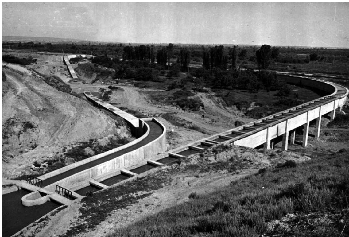
Samur-Abşeron kanalı üzərində hidrotexniki qurğu. 1955
