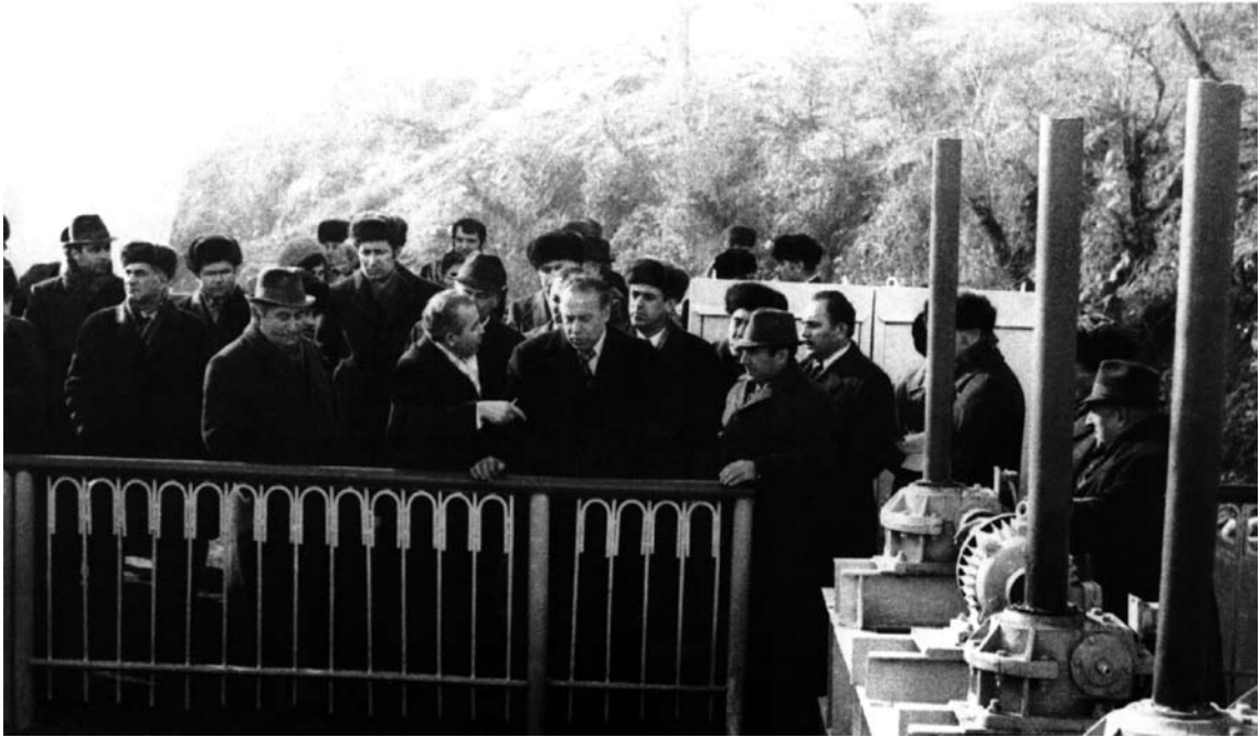
Heydər Əliyevə Başəriçaydakı hidrotexniki qurğu haqqında məlumat verilir. 1976
