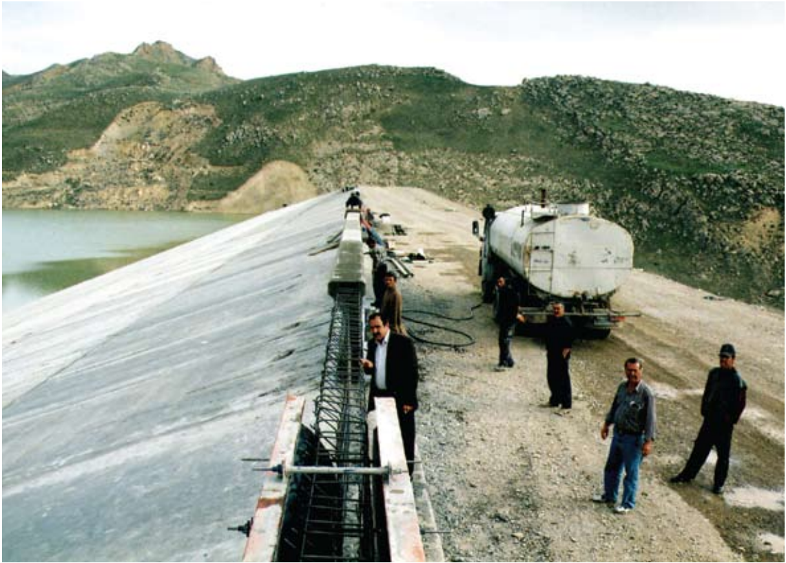
Vayxır su anbarında inşaat işləri tamamlanmaq üzrədir
