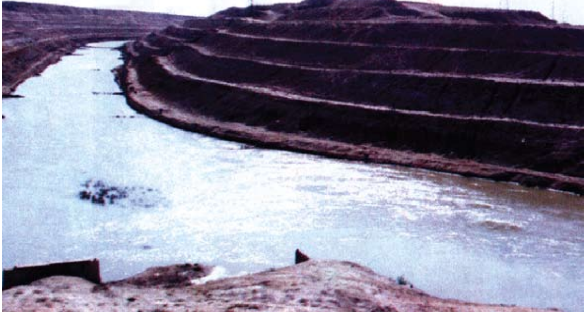
Baş Şirvan kollektorunun Şirvan şəhərindən keçən hissəsi. 1964
