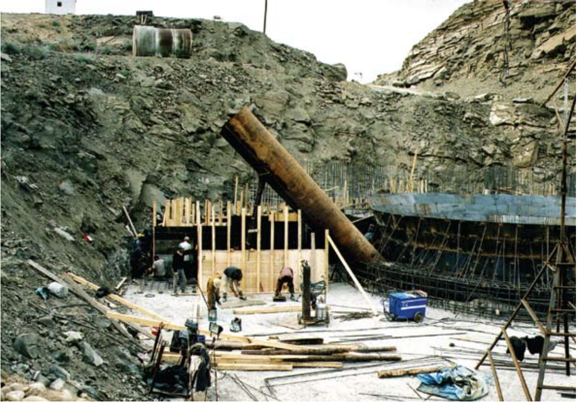
Vayxır su anbarında inşaət işləri aparılır
