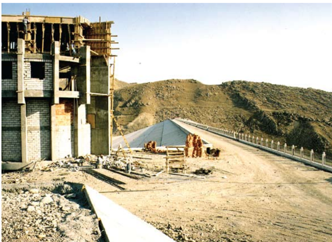
Vayxır su anbarında tikinti işləri aparılır.
