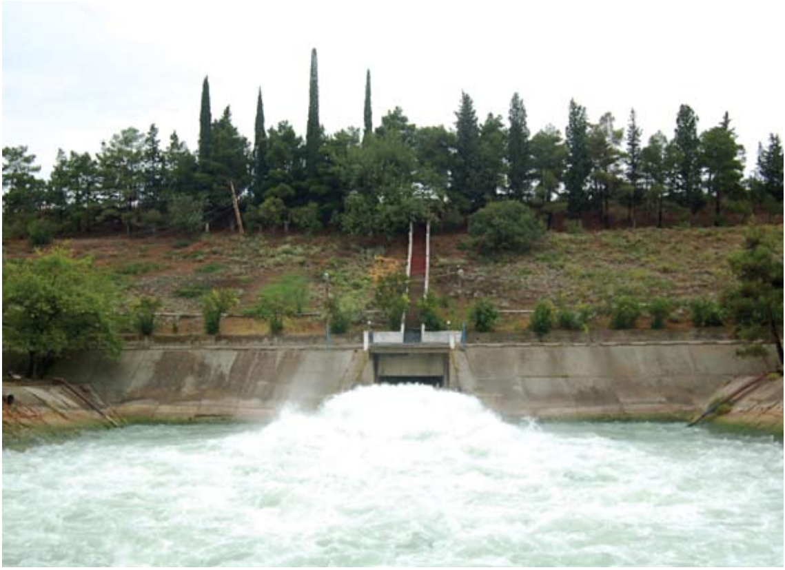
Yuxarı Şirvan kanalında baş suqəbuledici qurğu
