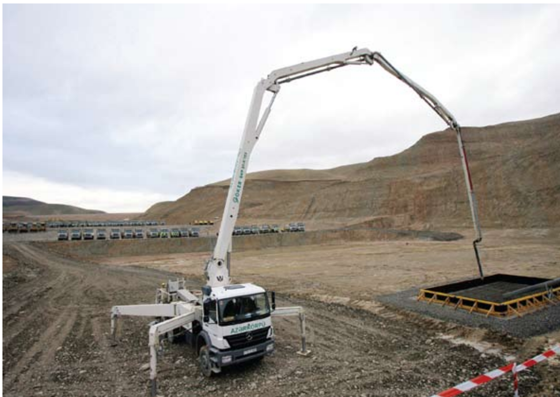
Taxtakörpü su anbarında bəndin özülünə beton verilir.
