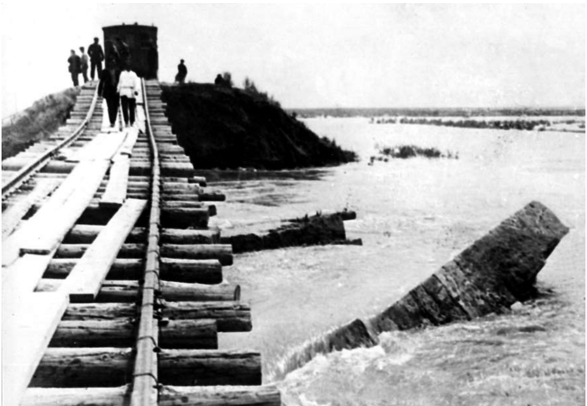
Daşqın suları nəticəsində dəmir yolunun bir hissəsi qəza vəziyyətinə düşüb
