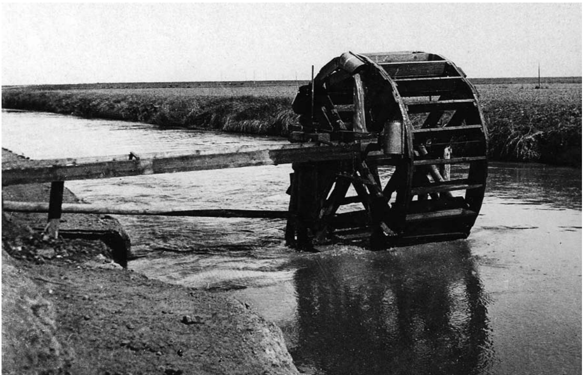
Əkin sahələrini suvarmaq üçün Kür və Araz çaylarında geniş istifadə olunmuş su çarxı. 1913
