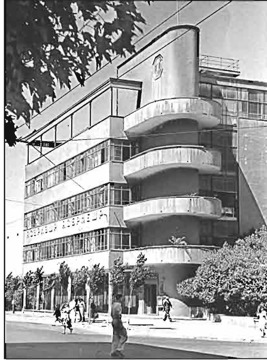
Mətbuat sarayının (Azərbaycan Dövlət Nəşriyyatı mətbəəsinin) Azərbaycan prospektindəki (keçmiş Bazarçaya küçəsi) binası. Bina 1931-1933-cü illərdə memar Semyon Pen (1897-1970) tərəfindən tikilmişdir. Hazırda binada kommersiya bankı yerləşir.
