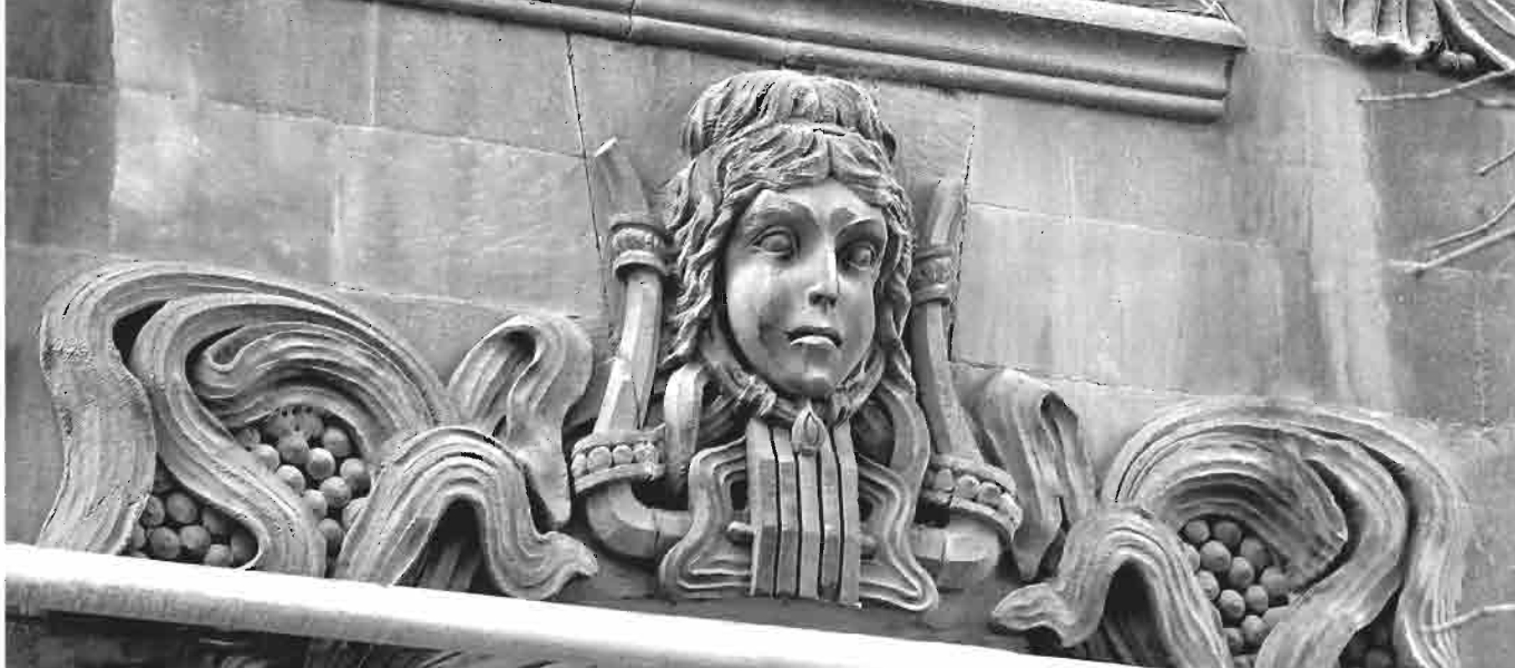
Yaşayış binasının əsas girişinin elementi, Mordanov qardaşları (keçmiş Praqaşağa) küçəsi, 15. Bina 1882-ci ildə tikilmişdir.
