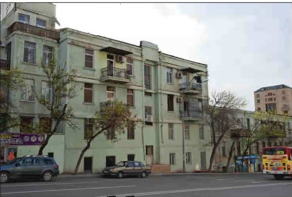
Красноармейская (indiki Səməd Vurğun) küçəsi, 54-də yerləşən yaşayış binası.
