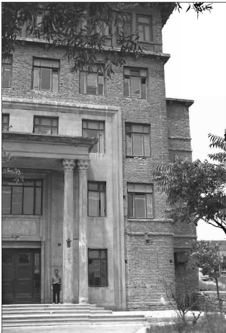
Сарыев (indiki Təbriz) küçəsindəki inzibati bina. Bina 1930-cu illərdə tikilmişdir.
