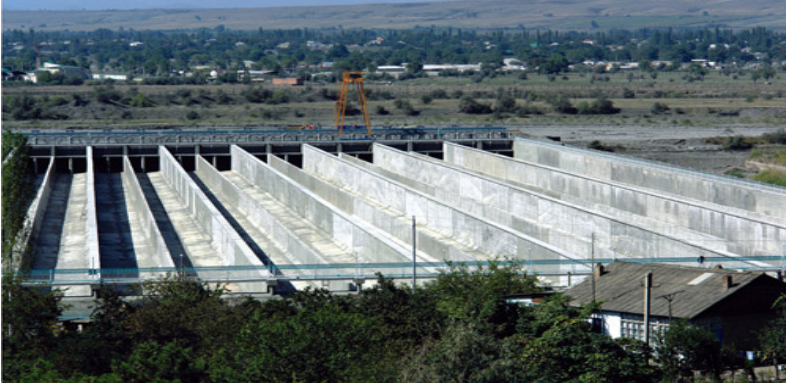
Samur-Abşeron su kanalının sudurulducu qurğusu 120
