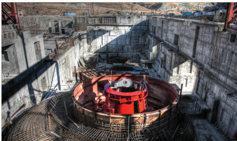
Kambar Ata-2 Su Elektrik Stansiyasının tikintisi
