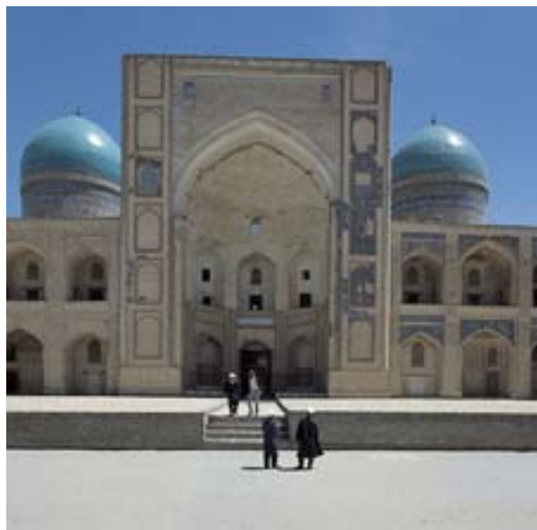
Fig. 14. Bukhara. Pāy-i Kalān. Mir-i ʿArab madrasa . (Photo: © UNESCO/A. Garde.)
