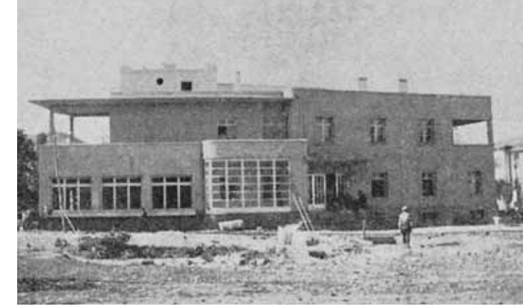
3 Kastamonu Halkevi inşaat halinde, 1939.
