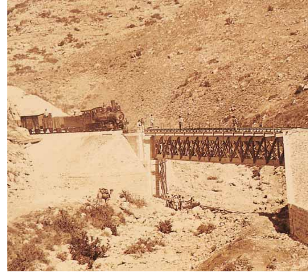
3 Hicaz Demiryolu. Yarmuk (Filistin) Vadisi'nde demir köprü (1903).
