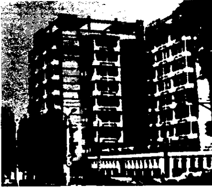
Şəkil 5.39. Karkas panel və iripanelli çoxseksiyalı yaşayış binası (1970-ci illər).
