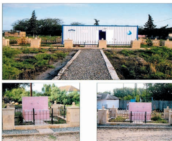
Kürdəmir rayonu, Mollakənd kəndində inşa edilmiş modul tipli sutəmizləyici qurğu və içməli su kranları.
